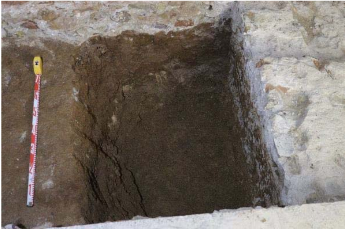
Fotografia 14. Vista de la cala oberta al tortorà a tocar de la fonamentació UE105.
