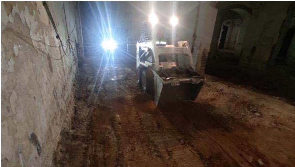
Fotografia 43. Una altra imatge de la màquina, extraient la runa de la solera (UE1003) a l'espai-8, des del nord.
