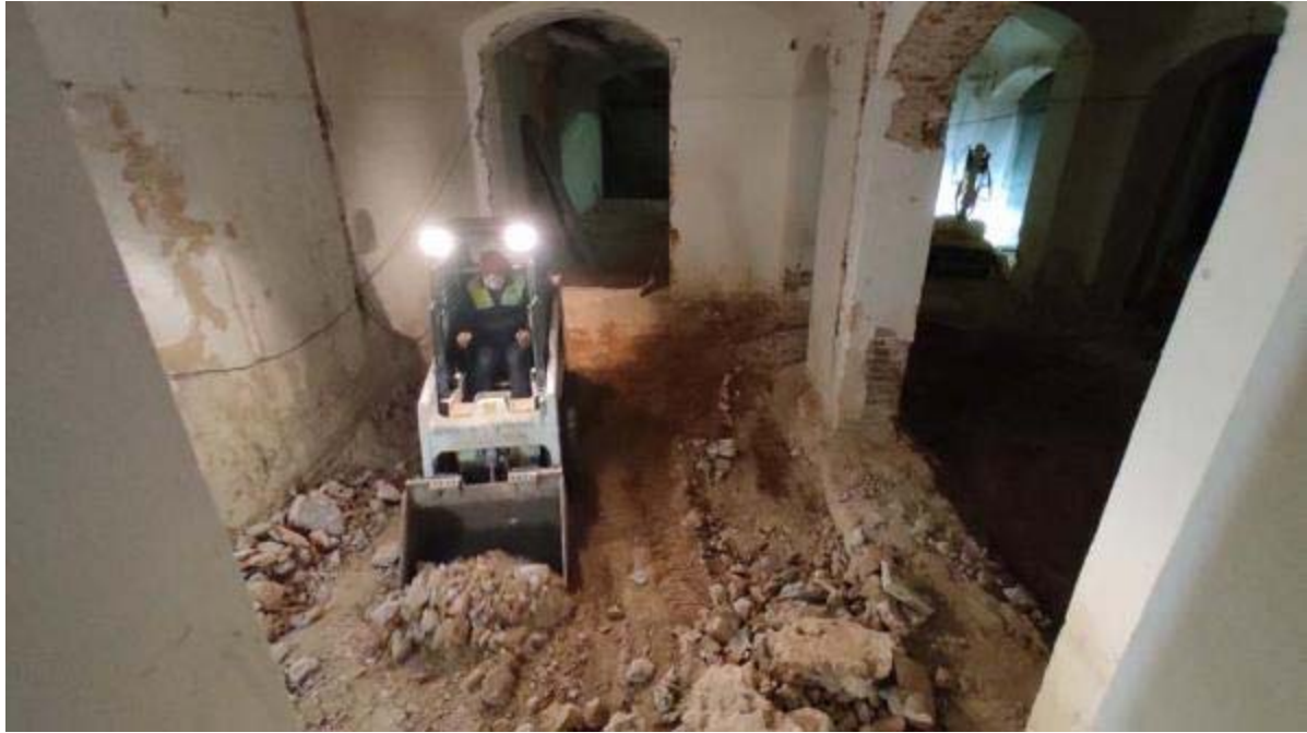
Fotografia 37. Una altra imatge de la màquina, extraient la runa de la solera (UE1003) a l'espai-8, des del nord.
