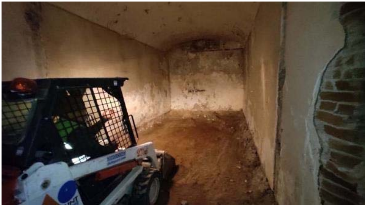
Fotografia 40. Imatge de la màquina tipus Bobcat, rasant els nivells sota els paviments, en aquest cas de l'espai-1, des del sud.
