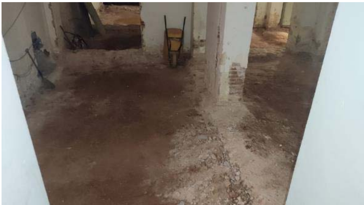
Fotografia 44. Vista final, de l'àmbit-8, després d'extreure els paviments (UE1001/1002) i la potent solera del soterrani (UE1003), on observem les argiles del terreny geològic, des del nord.
