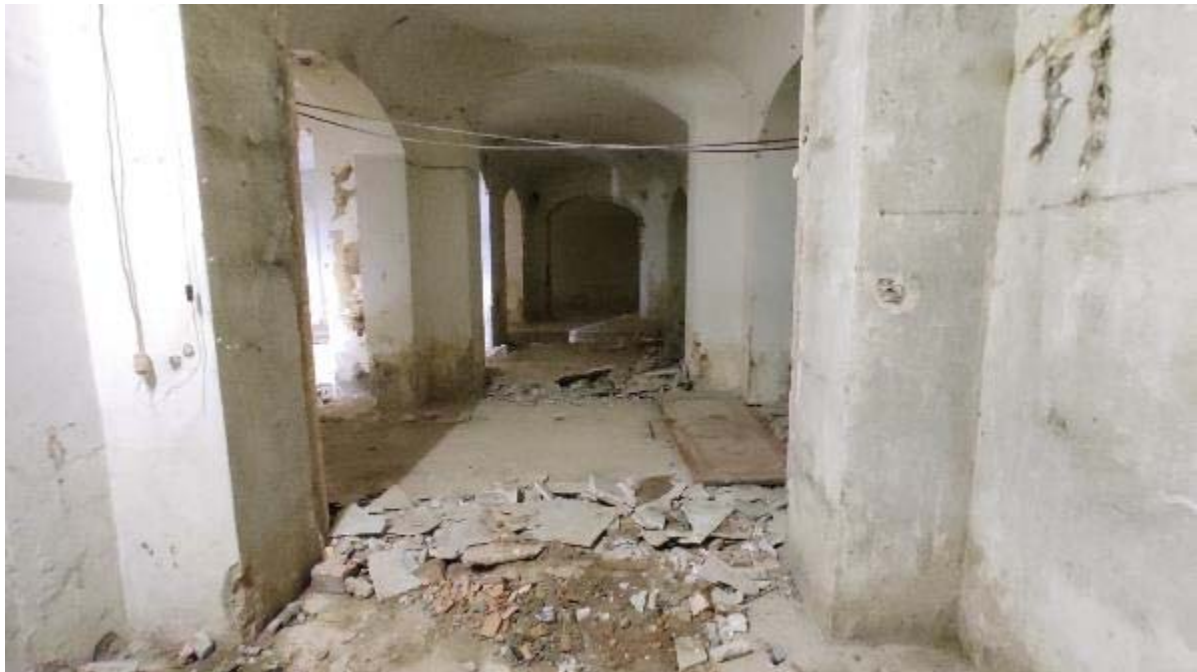
Fotografia 34. Imatge de l'espai-14, just després d'extreure els paviments (UE1001/1002) del soterrani i la potent solera (UE1003), des del sud, a l'espai-19.
