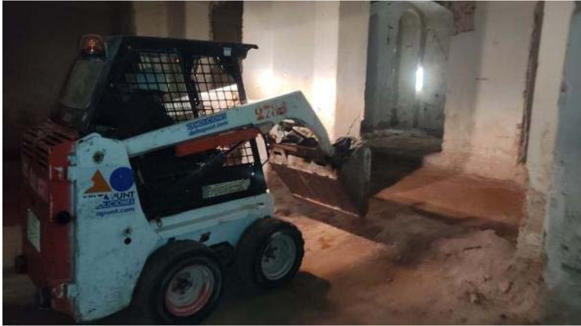
Fotografia 39. Panoràmica del seguiment de les tasques d'extracció dels paviments a l'espai-18, del soterrani, des de l'est, on observem les argiles del terreny geològic.
