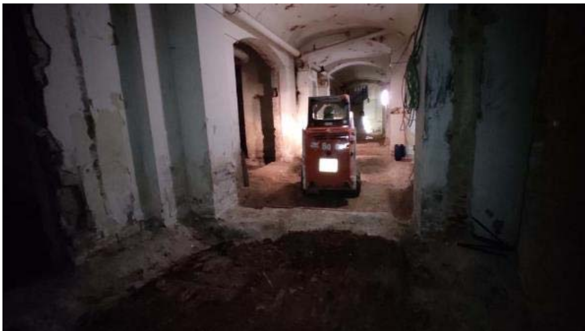
Fotografia 46. Imatge de la màquina, extraient les restes de la solera del soterrani (UE1003), i localitzant el terreny geològic (argiles vermelloses, amb nòduls de carbonats) a l'espai-16, des del sud.
