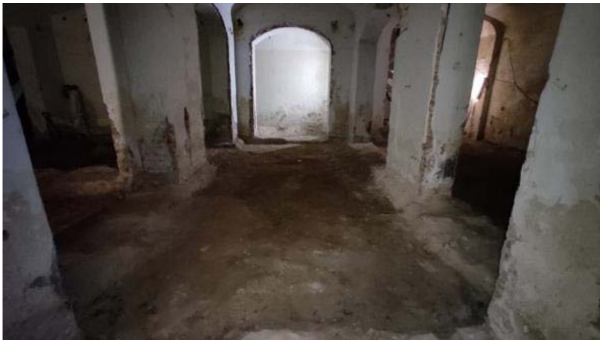
Fotografia 45. Panoràmica final de l'àmbit-7, després d'haver extret els paviments i la solera, i haver rascat el subsol, localitzant les argiles del terreny geològic.
