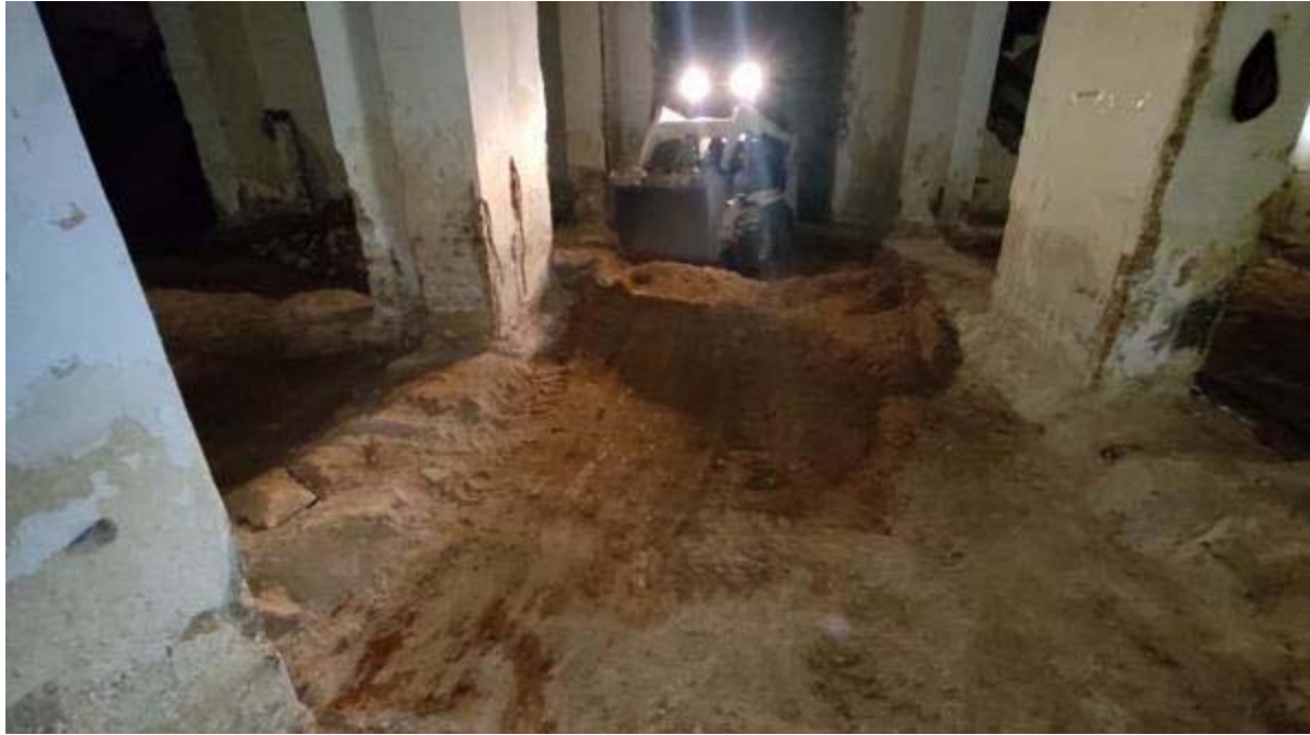
Fotografia 41. Vista de la màquina treballant a l'espai-13, localitzant els nivells d'argiles vermelloses del terreny geològic de la zona, des del sud, un cop extrets els paviments i la solera.
