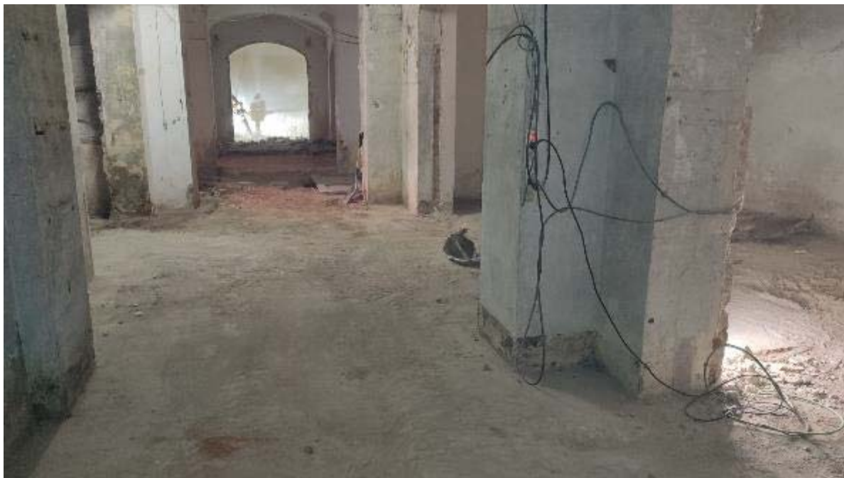
Fotografia 35. Panoràmica dels l'espais centrals (23/18/13/7 i 3), just després d'extreure els paviments i la potent solera del soterrani (UE1003), des del sud, a l'espai-23.
